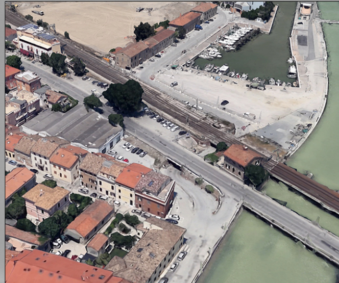
nuovo sovrappasso ferroviario via Sanzio-area Sacelit Italcementi (in previsione)
