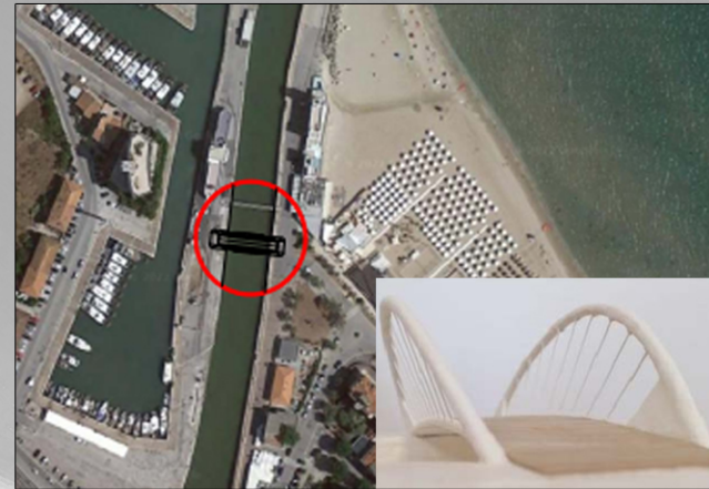
2.1 Rifacimento ponte ciclopedonale
