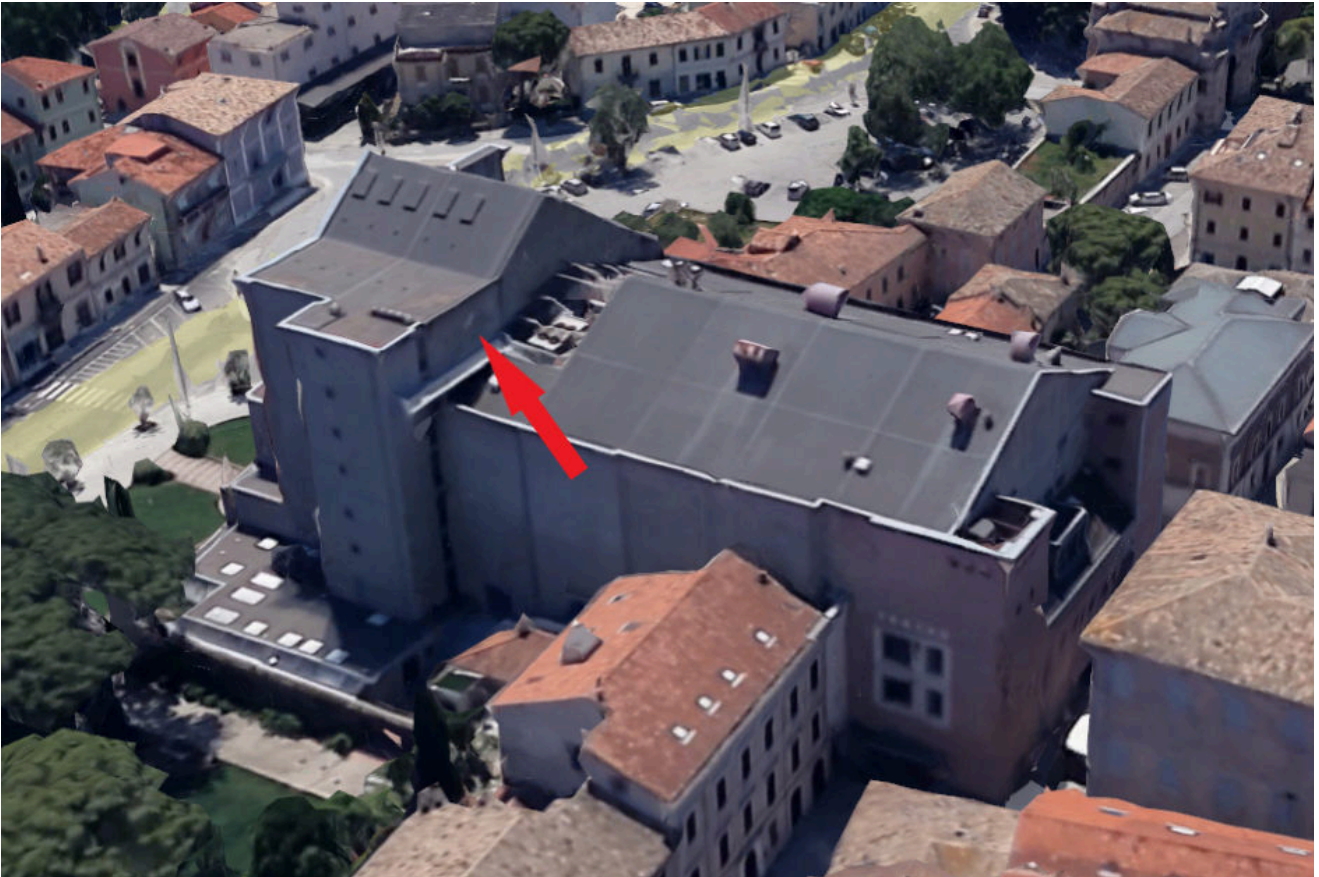
Fig.24: Edificio del Teatro la Fenice con indicata la postazione di progetto per la SRB
