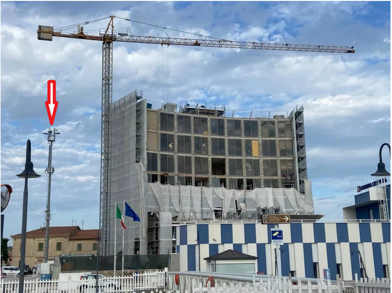
Fig.25: SRB esistente a fianco dell'Ex Hotel la Vela in ristrutturazione
